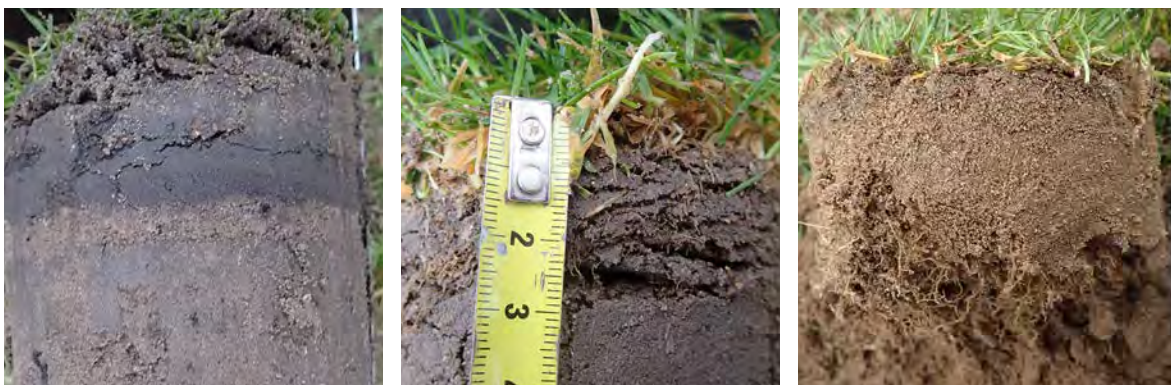
Figuur 3 Hoge humusgehalten in de bovenste centimeters - hier door toepassing van graszoden (l) - en een dikke viltlaag (m) zijn ongewenst. De aanwezigheid is visueel eenvoudig te beoordelen.
